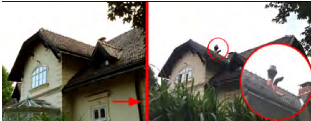
Patentiertes RoofTop-System (Aufstellung des Aussengerätes im Dachboden)
