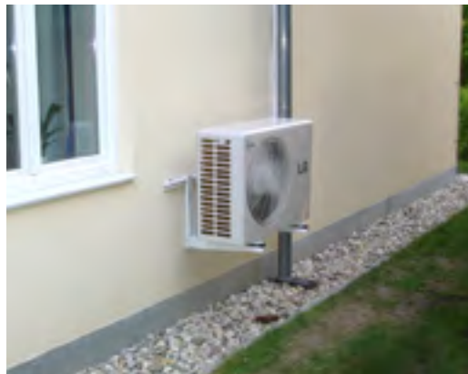
Single-Split Ausseneinheit 3,5kW
