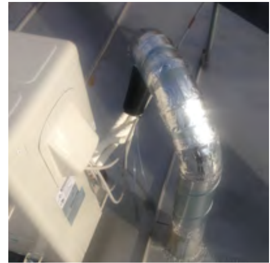
Dampfsperren/Dampfbremsen werden fachmännisch wiederhergestellt
