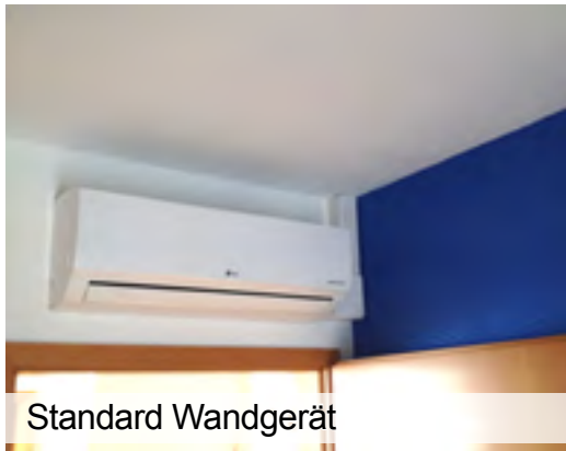
Aufputz mit Eck-Kondensatpumpe
