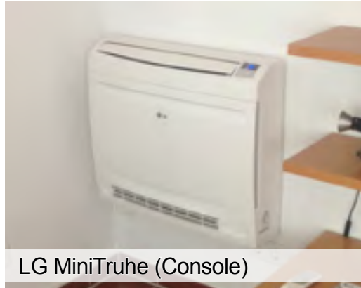
Aufputz mit Eck-Kondensatpumpe
